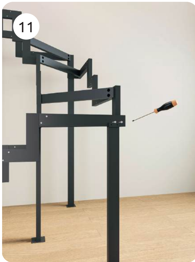
11. Закрепляем их болтами.
