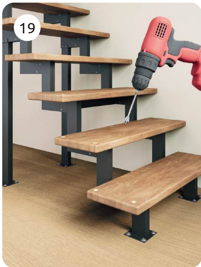
19. Делаем отверстия в ступенях для опор ограждения.
