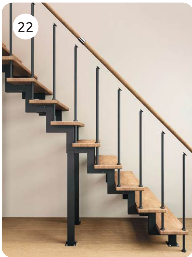
22. На опоры ограждения устанавливаем поручень.
