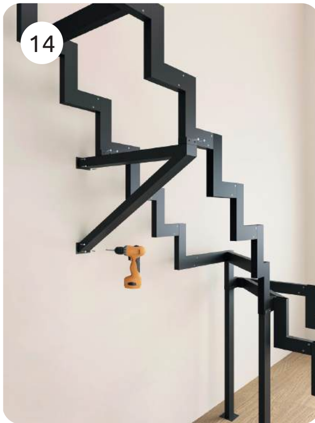
14. При необходимости устанавливаем опоры в стену.
