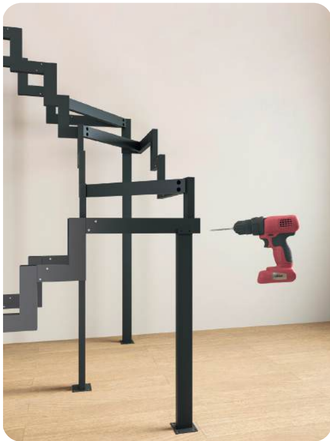
10. Сверлим отверстие в модуле для фиксации с опорой.
